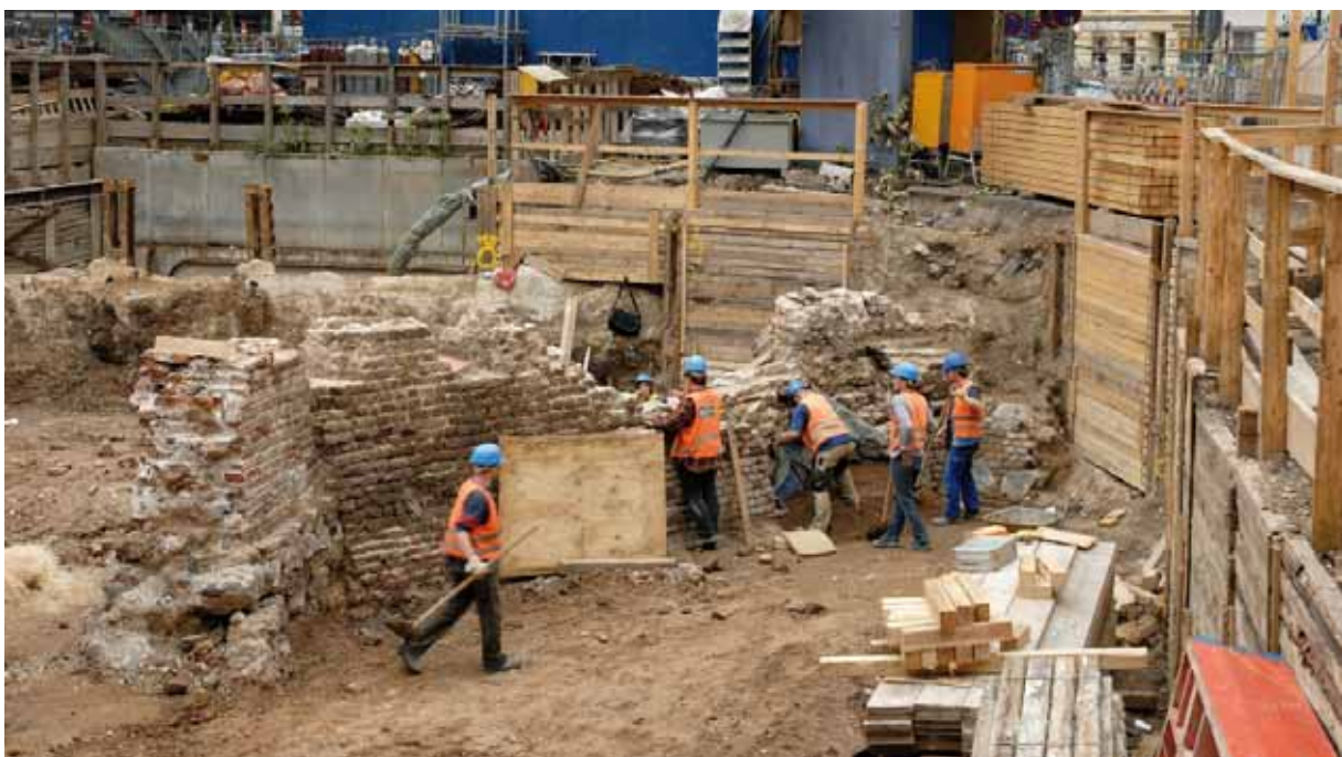
Der „Zwinger“ schützte die Severinstorburg vor feindlichen Angriffen.
