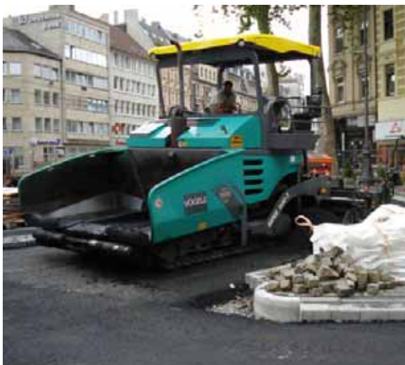
Asphaltieren und walzen der endgültigen Oberfläche im Straßenbereich.
