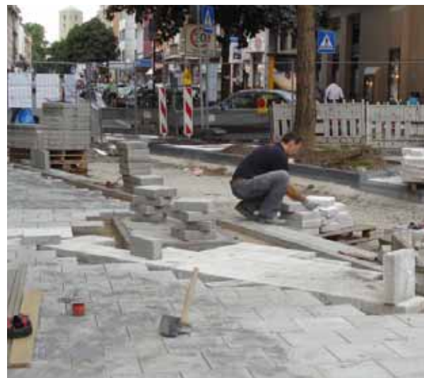
Ausführung der Pflasterarbeiten für die Neugestaltung der Bürgersteige.
