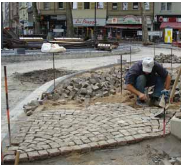
Ausführung der Pflasterarbeiten für die Neugestaltung der Bürgersteige.
