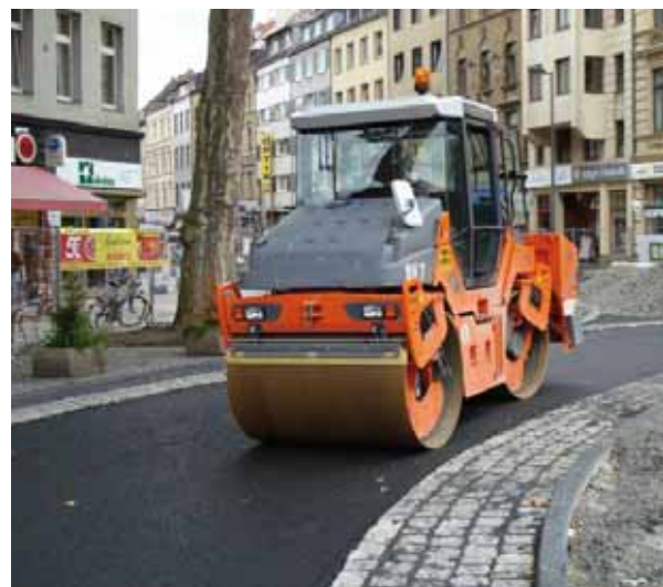
Asphaltieren und walzen der endgültigen Oberfläche im Straßenbereich.
