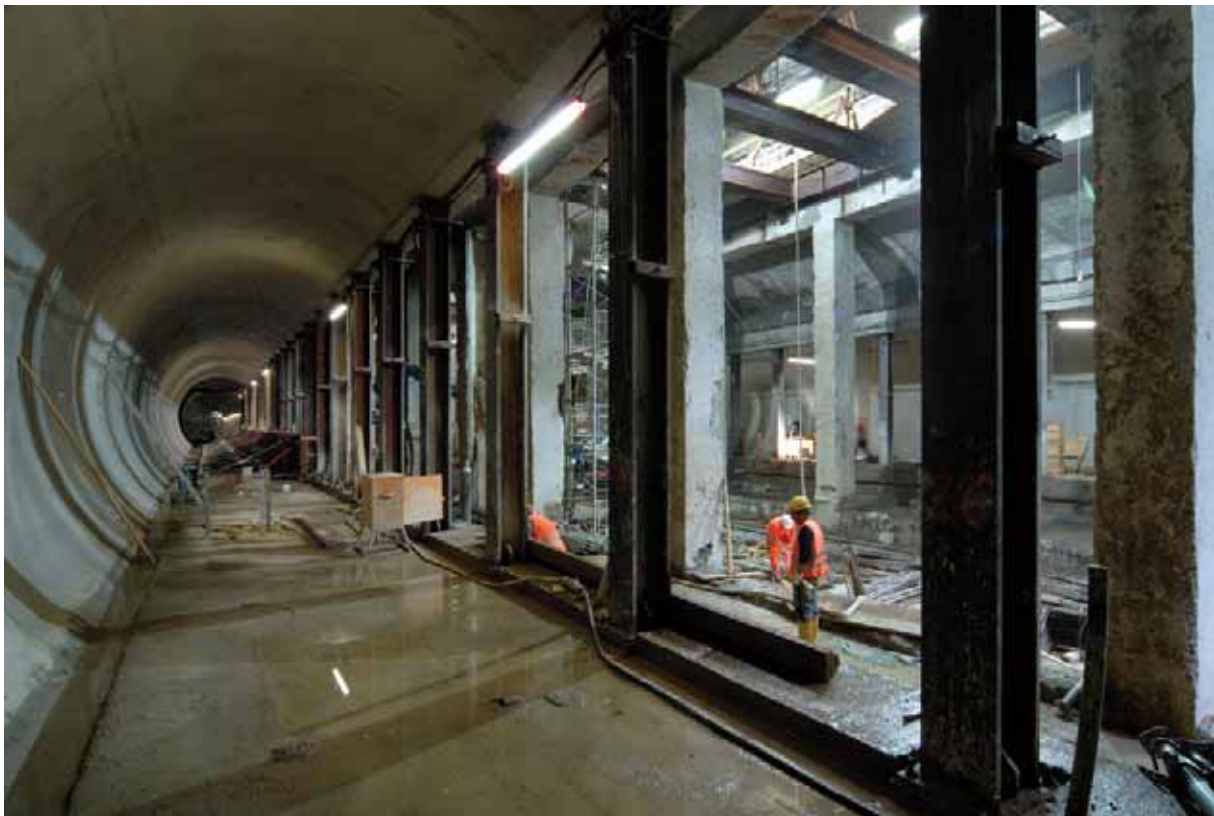
Gleisebene Chlodwigplatz nach dem Aufbruch der Schlitzwände und der Tunnelröhren.
