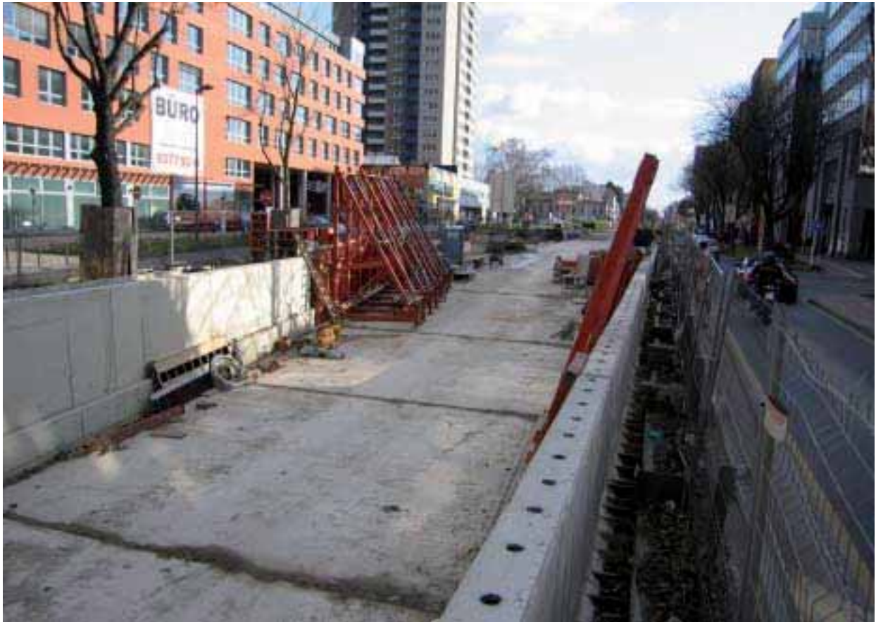
Abb. 15: Rampe zur Haltestelle Marktstraße
