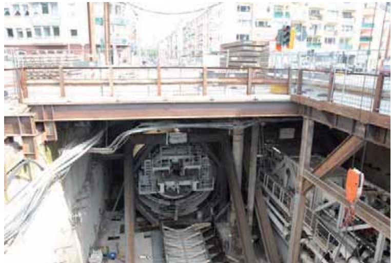
Abb. 3: Blick von hinten in den Bohrkopf der Maschine „Rosa“ (in der Anfahrtkonstruktion)
