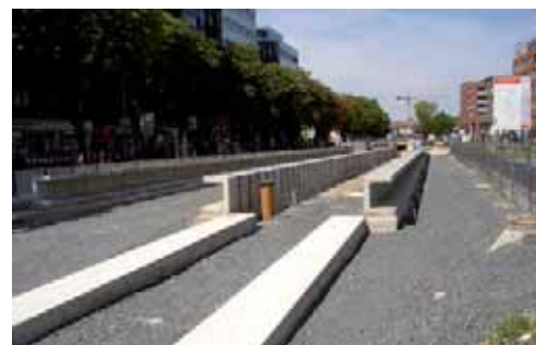
Abb. 6: Die neuen Bahnsteigkanten
