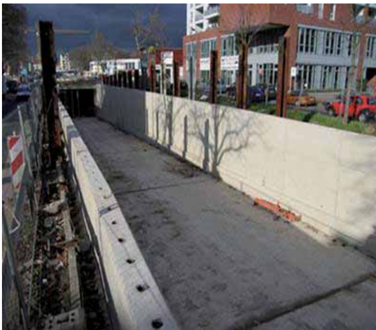
Abb. 16: Trogbauwerk mit Stahlträgern
