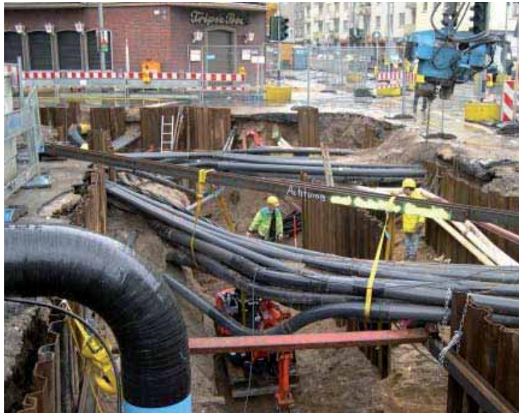
Abb. 8: Leitungsverlegungen vor der Tankstelle
