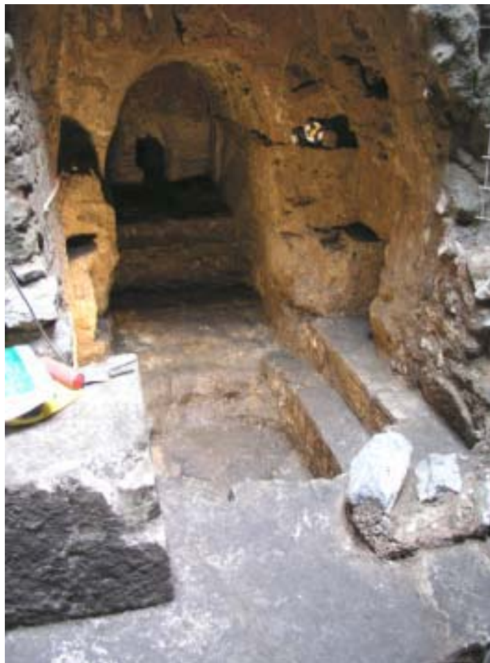
Abbildung 5 Auslasskanal aus römischer Zeit
