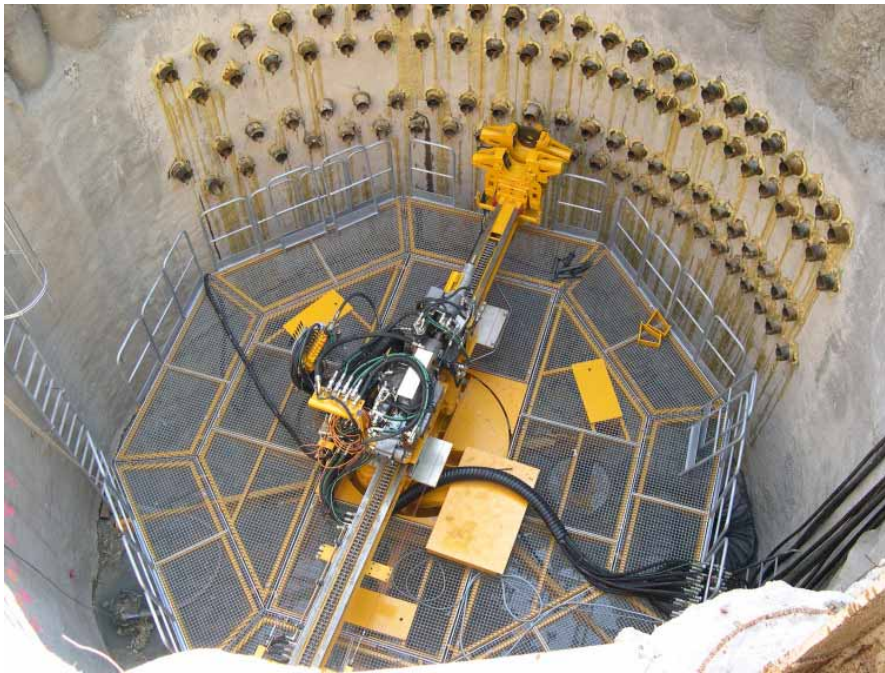
Abb. 19: Kompensations-Injektionsschacht
