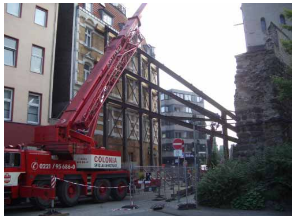
Abb. 20: Abstützung des Hauses Severinstraße 1
