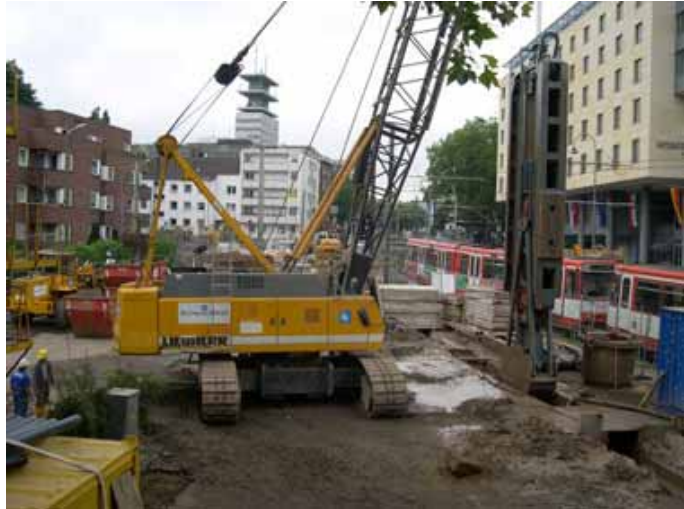
Abb. 3: Schlitzwandherstellung parallel der Augustinerstraße
