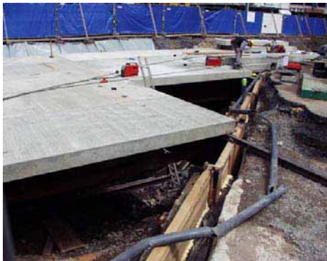
Abb. 4: Baugrubenabdeckung Augustiner/Pipinsstraße
