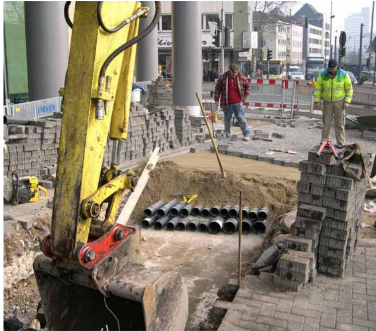
Abb. 2: Verlegung von Leitungen parallel zur Augustinerstraße
