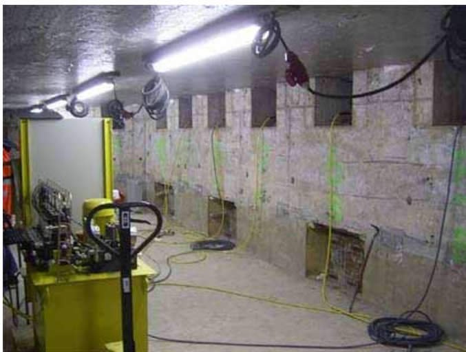
Abb. 6: Balken mit Pressennischen
