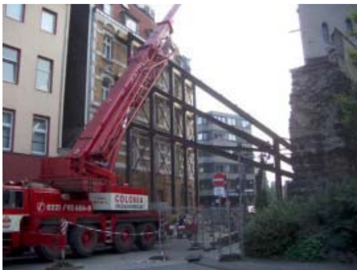
Abbildung 13: Stahlträgerabstützung an der Severinstraße
