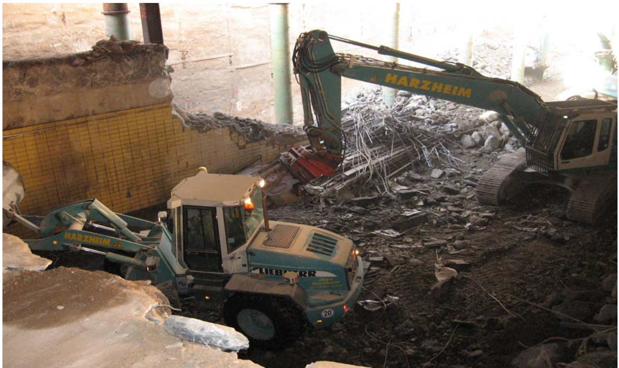
Abb. 1: Abbrucharbeiten an der Haltestelle
