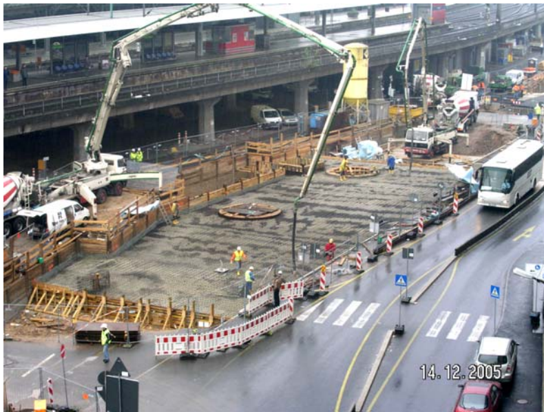
Abb. 10: Betonieren des Deckels
