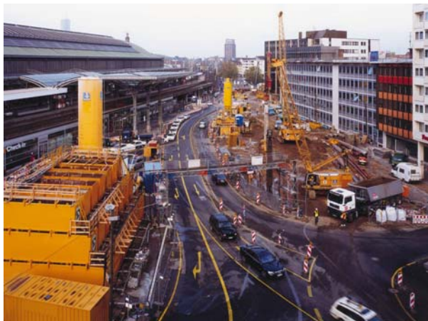
Abb. 8 und 9: Errichtung von Baugrubenumschließungen am Breslauer Platz
